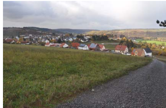
Blick nach Norden auf die bestehende, erste Bebauung an der Erschließungsstraße „Am Kies“
