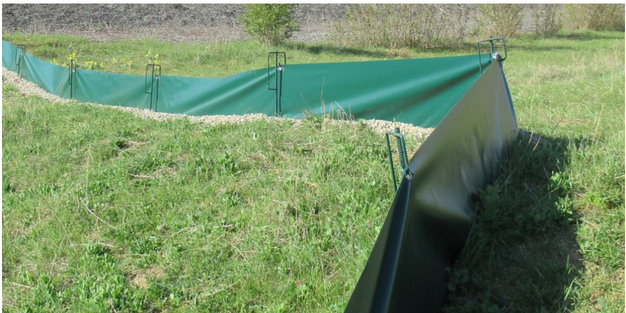
Abbildung 14: Korrekt aufgestellter Reptilienzaun mit glatter Oberfläche; Quelle: saP (FABION GbR, 2021)
